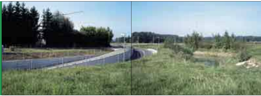
«Unders Tägermoos» nach dem Bau der Anschlussstrasse bei Tägerwilen TG (18.09.2002)
