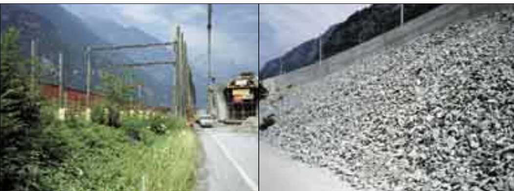
Talboden bei Pozzo Negro TI während dem Bau des Südportals (19.06.2002)
