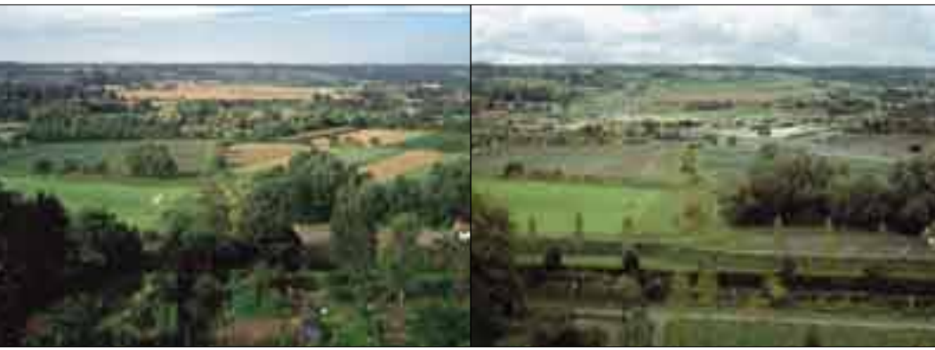
Kulturlandschaft «Töbeli» vor und während dem Bau der A7-Zollanlage TG (05.08.1997 / 07.10.2002)
