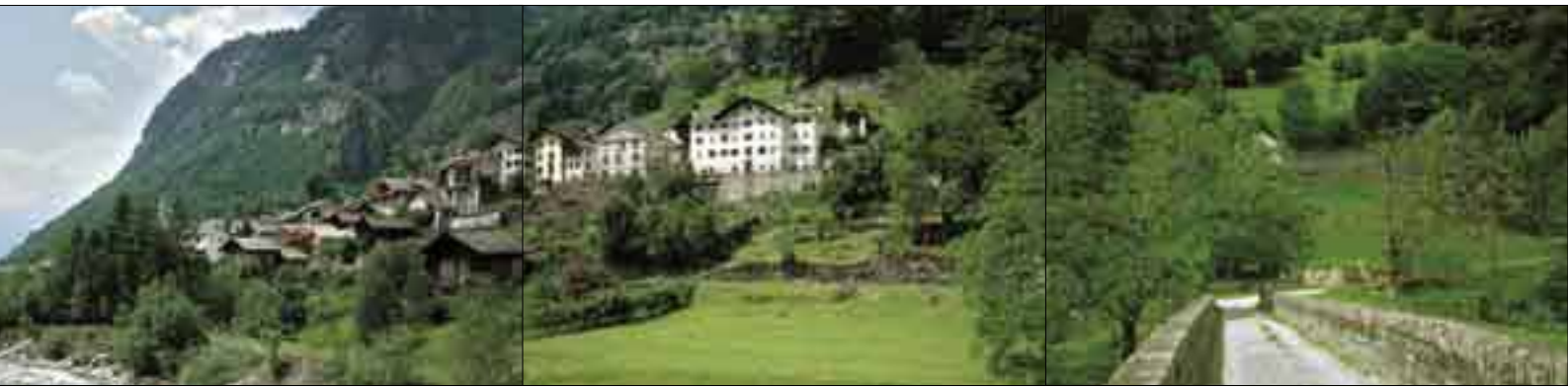
Castasegna GR vor dem Bau der Umfahrungsstrasse (21.07.1996)
