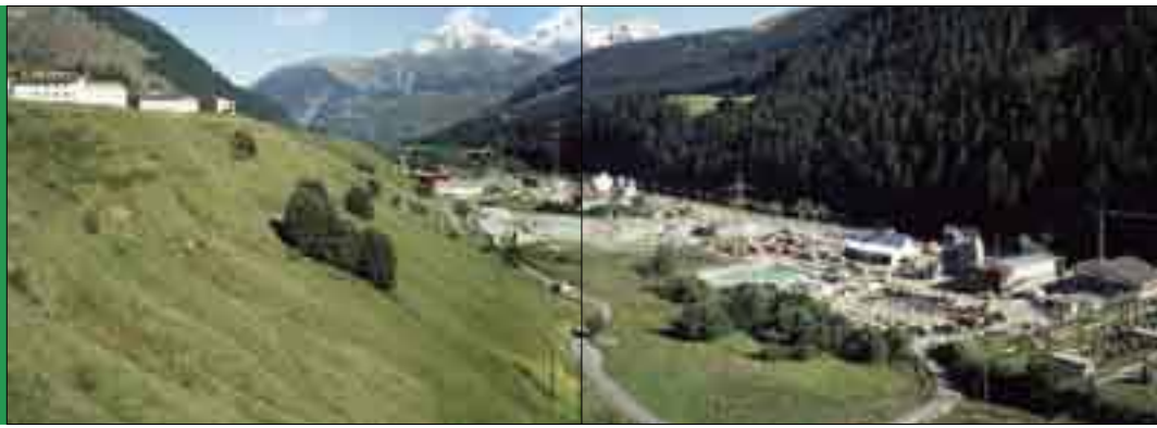
Sedrun GR nach Inbetriebnahme des Installationsplatzes Bau AlpTransit (18.09.1998)
